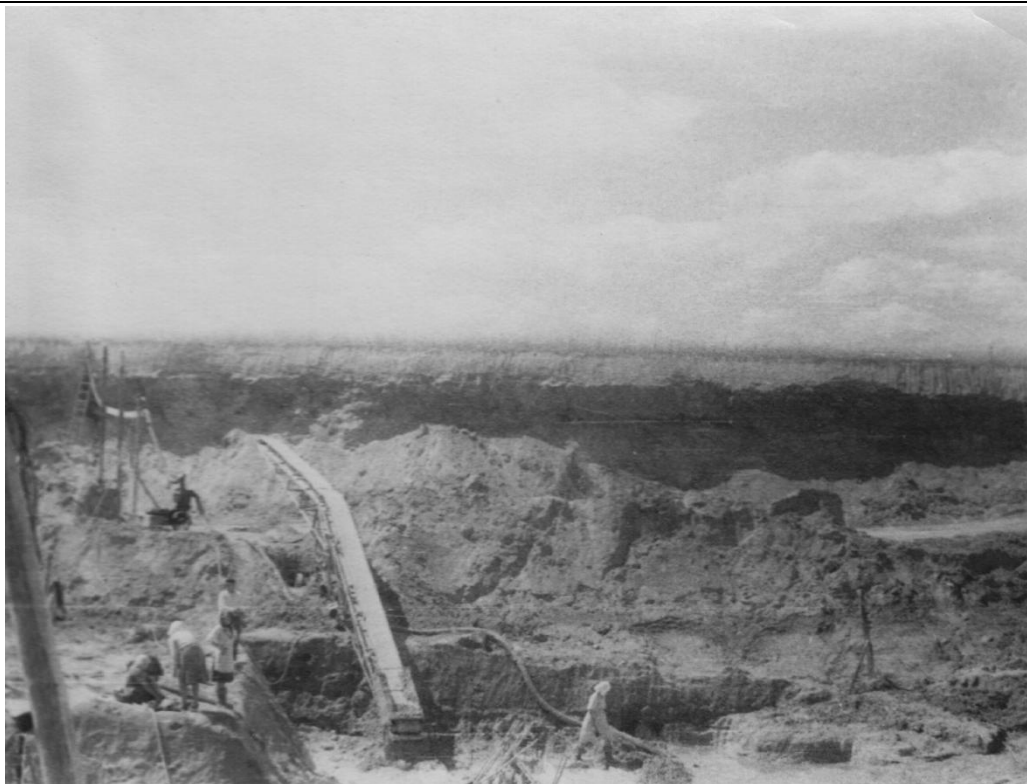
Фото 9. Проходка карьеров с применением отгрузочных средств, видна дорожка для вагонеток с породой, выгружаемой в терриконы.
