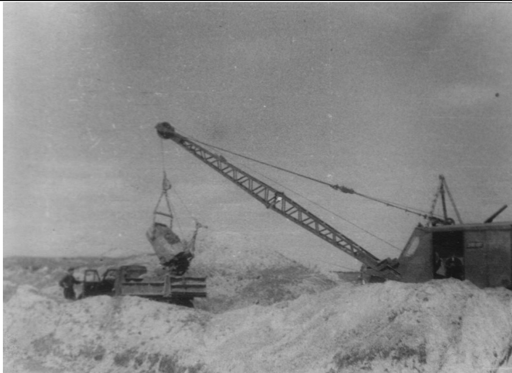
Фото 7. Разведочные работы шурфованием
